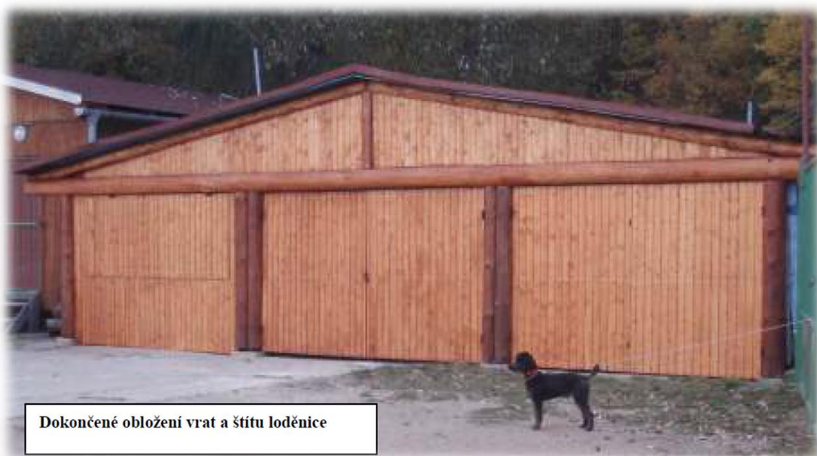
Dokončené obložení vrat a štítu loděnice
